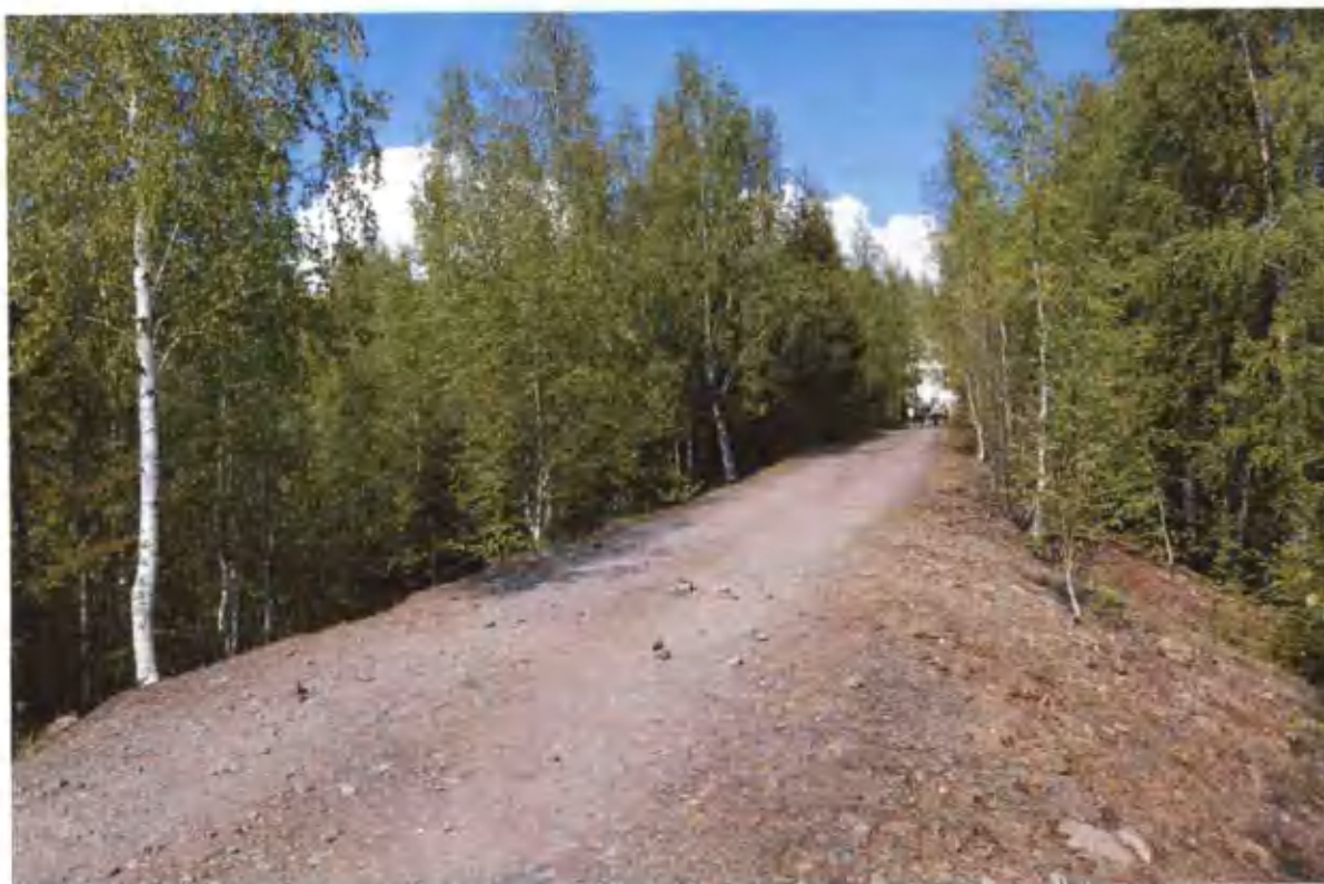
Рис. 3. Дамбы, отсыпанная материалом из отвалов старых шахт
